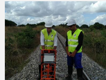
Verificação das tensões no carril (Corredor de Nacala)
