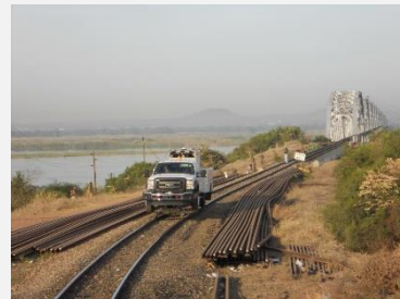
Inspeção Ultrassons na Linha de Sena (Ponte Dona Ana)
