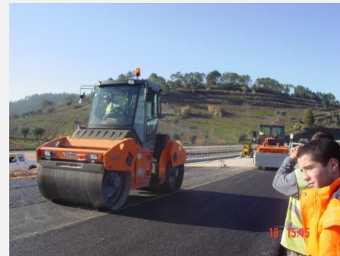
Obra de Pavimentação
